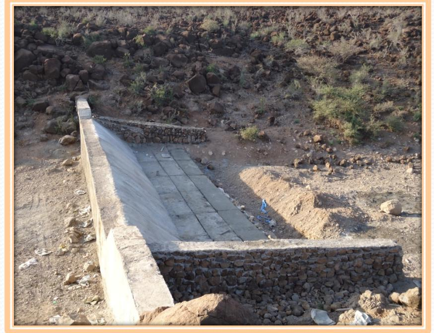
Ouvrage destiné au stockage de l'eau et la recharge de la nappe
